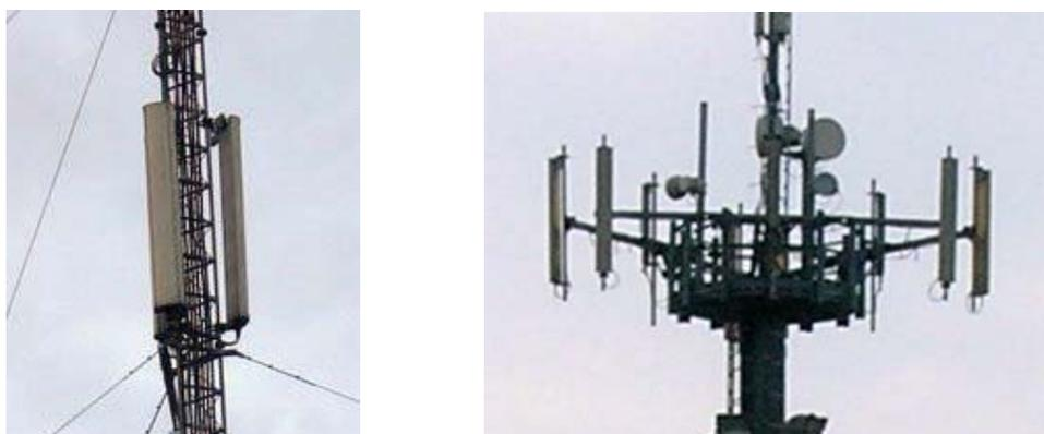
**Figura 2. SRB con antenne multi-banda (sinistra) o con tre gruppi di antenne (destra).**
